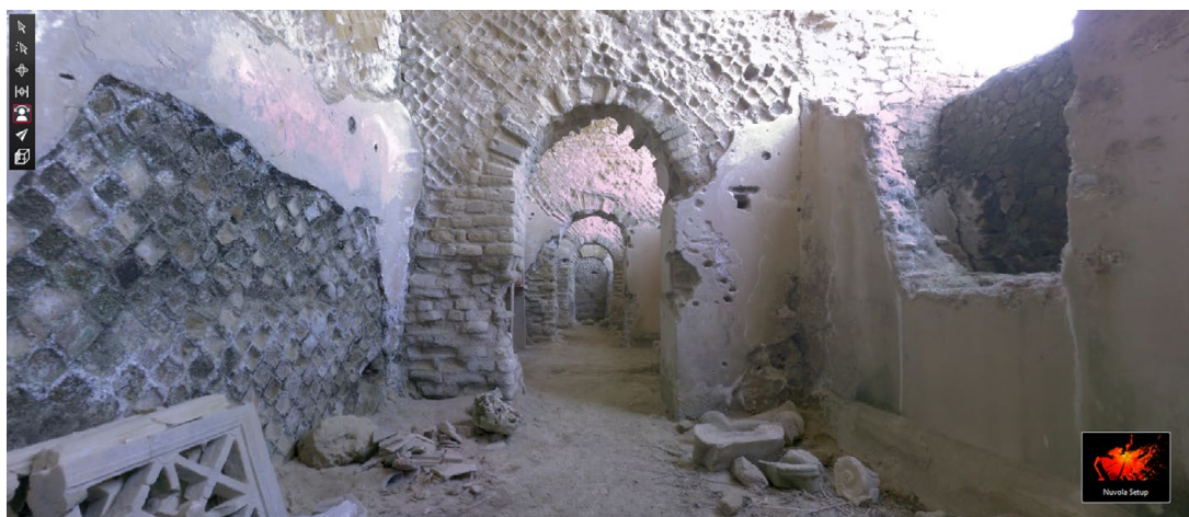
Fig. 2. Texturizzazione della scansione e restituzione realistica delle volumetrie delle Cisterne della Villa dell' Ambulatio (rilievo e elaborazione F. Cubellotti).
